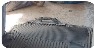
Espalhe com a lado liso da desempenadeira a mistura da argamassa, passe o lado dentado em ângulo, formando cordões e sulcos e paralelos. Pressione a placa até conseguir o amassamento dos cordões
